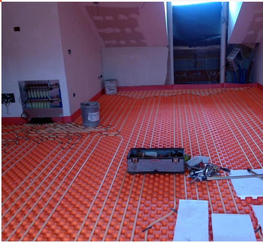
Impianto Radiante a pavimento, per un totale di circa 1 Km di tubazione
