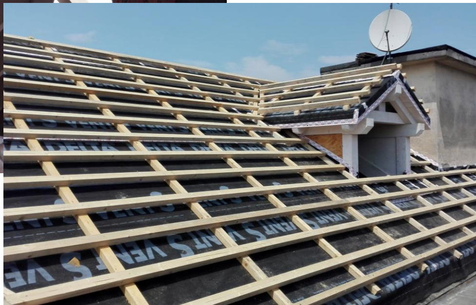
Vista esterna dopo la posa degli isolanti e della Listellatura porta tegole
